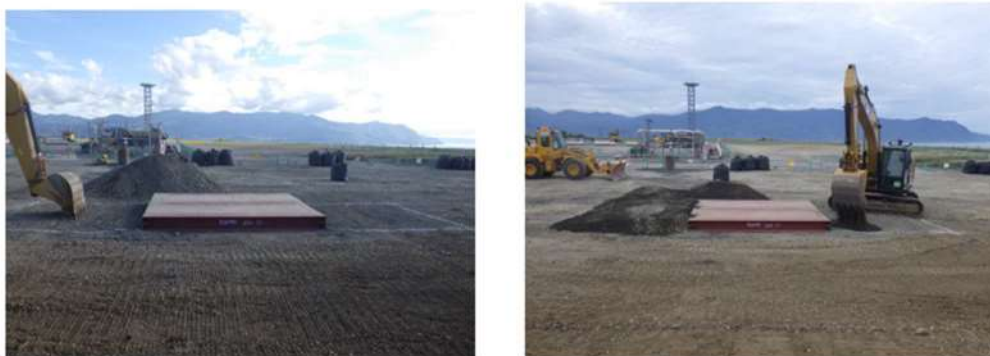
第10図 段差復旧状況
