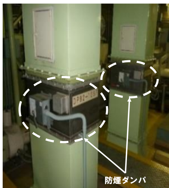
第 1 図 防煙ダンパ及び一括操作盤の設置状況
