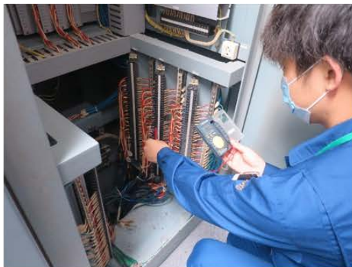
仮設計器による温度確認の一例
