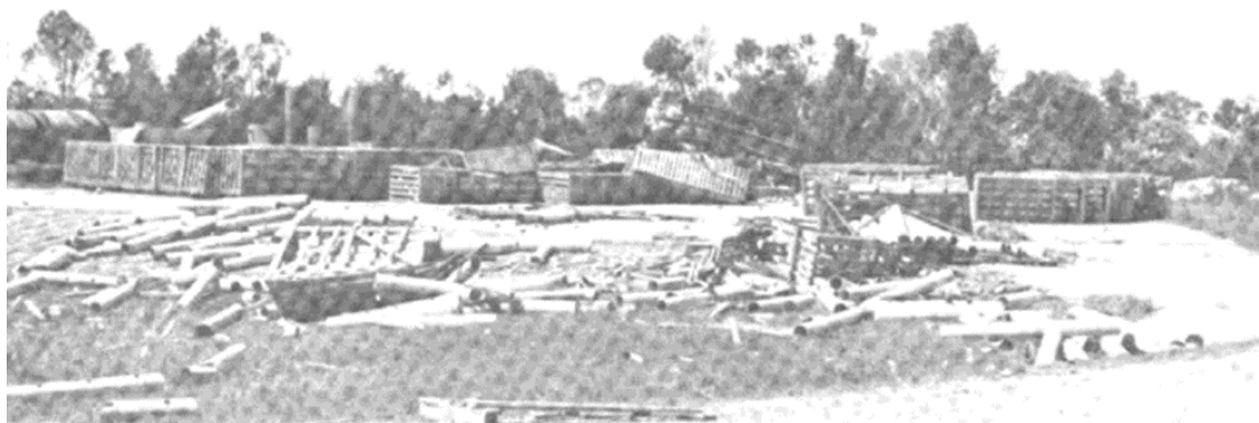
第 2.1 図 米国 Grand Gulf 原子力発電所における竜巻による資材置き場パイプの飛散状況
