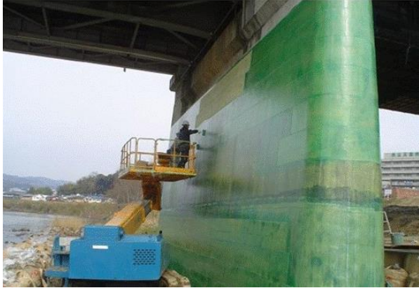
(a) 橋脚補強
