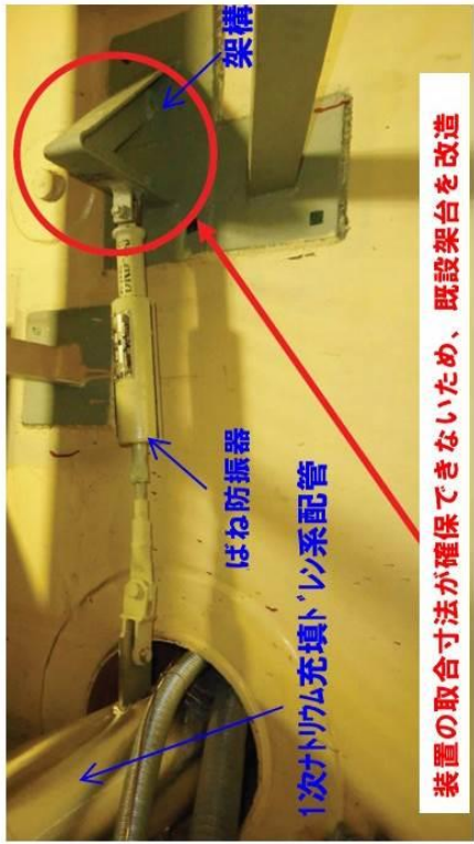
ばね防振器からメカニカル防振器への交換の例①
