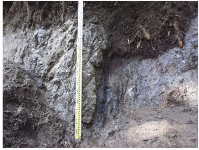
写真① 断層部の全景
