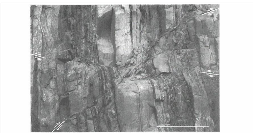
図II.1-8 共役断層の例(アルゼンチンのアンデス山脈東部) この露頭面は垂直で、地層はほぼ垂直に傾斜している。右上から左下へ延びる断層では上盤が右上へ衝上し、ほぼ水平にある断層では上盤は右から左へ衝上している。2つの断層が交差する部分では、断層が分岐して複雑な形態をとる。スケールバー=1 m.
