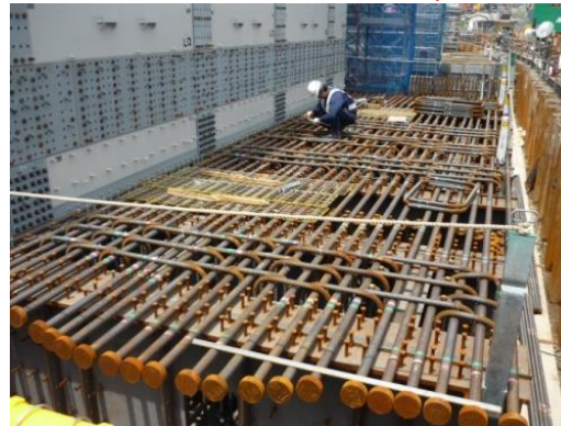
フーチング組立状況
