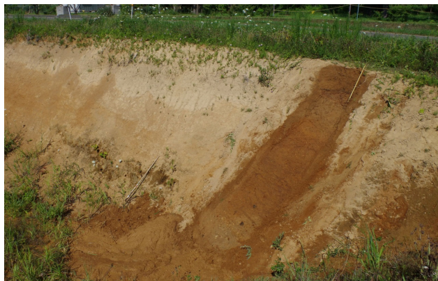
露头周辺状況(Loc.2)
