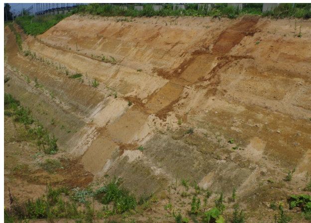
露头周辺状況(Loc.1)
