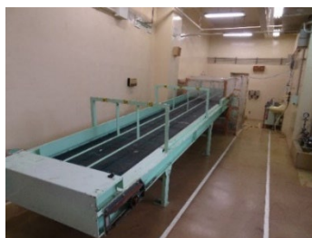
固体廃棄物投入機
