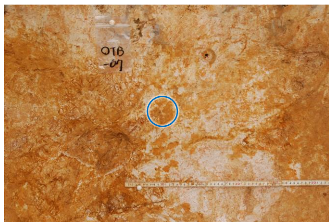
試料採取箇所写真(OTB-07)
