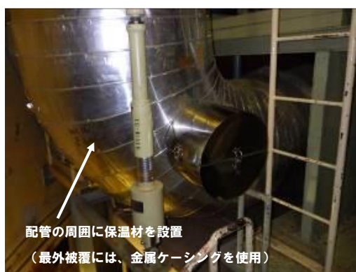
(1次主冷却系の配管)
