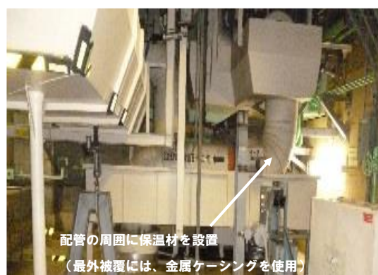
(2次主冷却系の配管)
