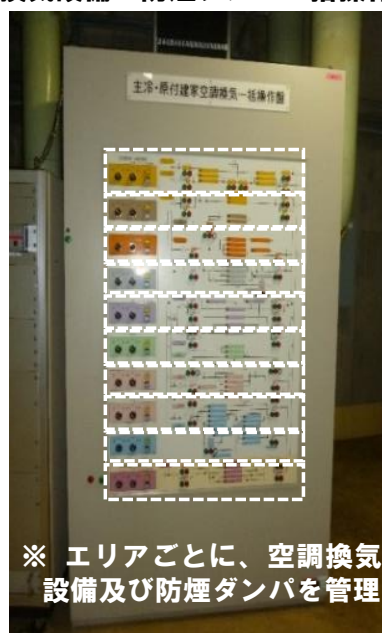
第 1 図 防煙ダンパ及び一括操作盤の設置状況
