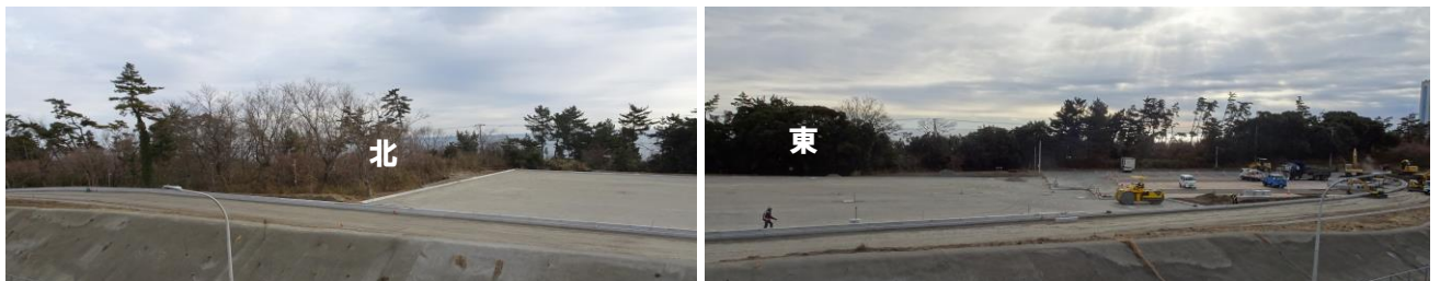
第2図 拡張した駐車場周辺の樹木の状況
