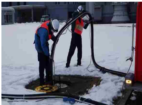
吸管を挿入する停注隊
