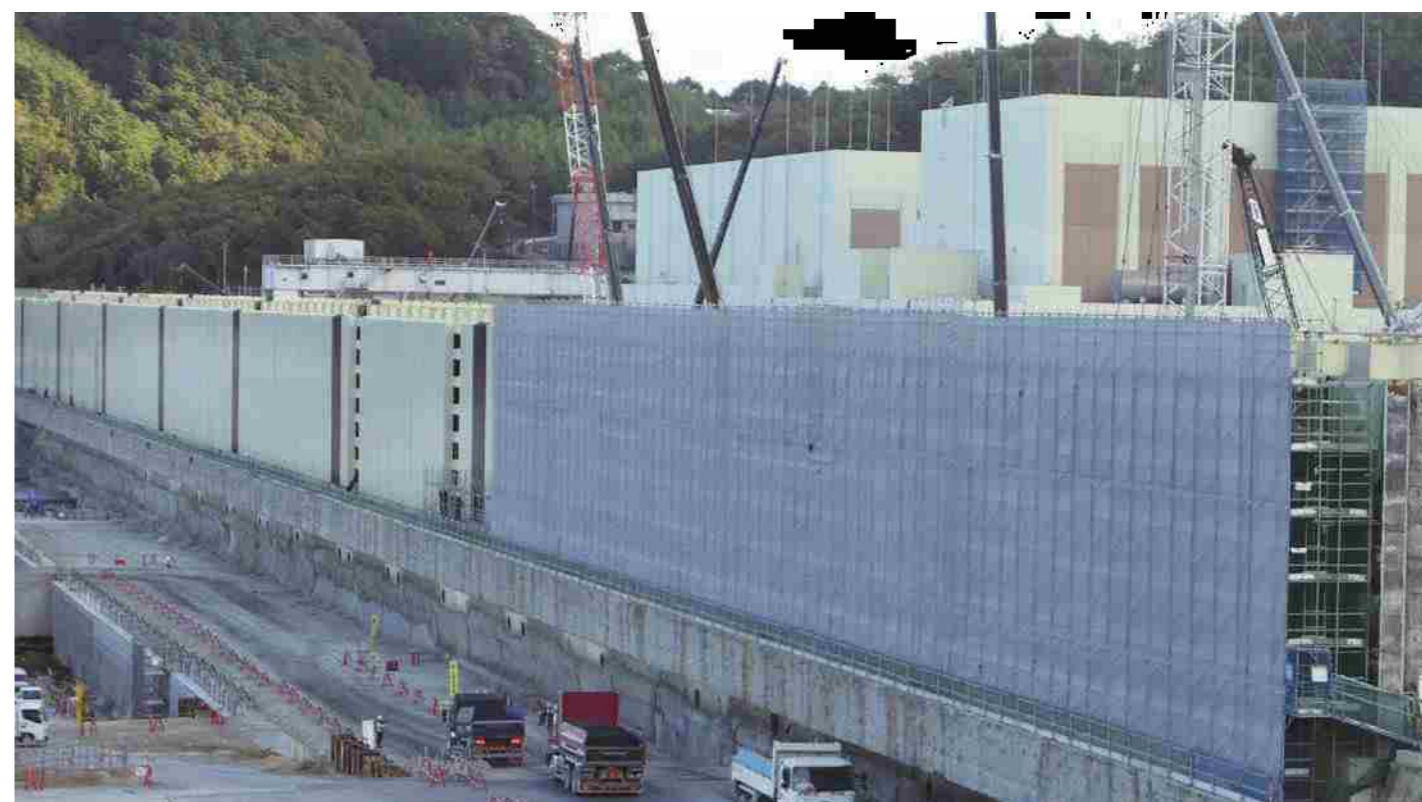
安全対策工事が進む女川原子力発電所(2022年10月撮影)
