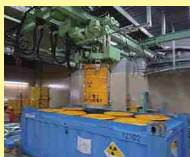
充填固化体を専用の輸送容器に収納し、容器表面の放射線量などを検査。
