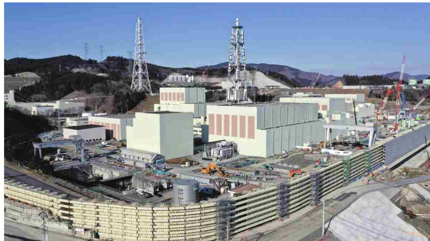
安全対策工事が進む女川原子力発電所(2022年2月撮影)
