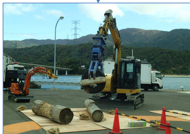
無線ヘリによる上空からの偵察結果を受けた 無線重機による瓦礫撤去
