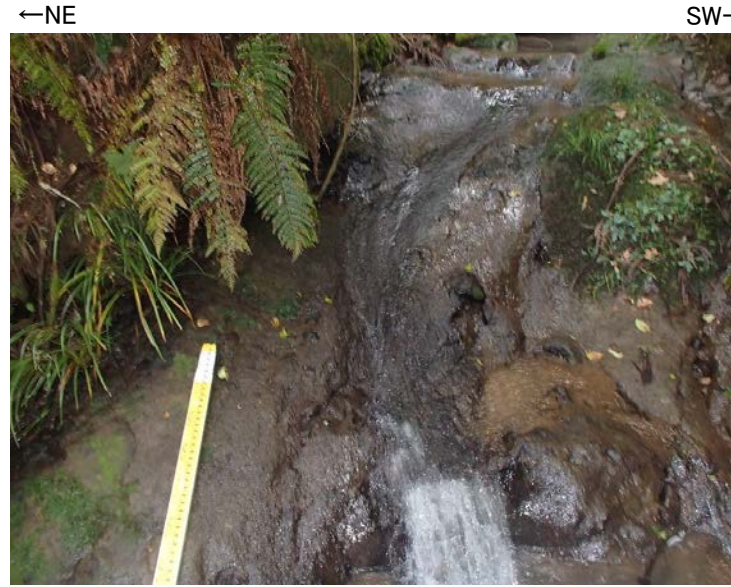
露頭写真① 凝灰角礫岩が分布し、断層は認められない
