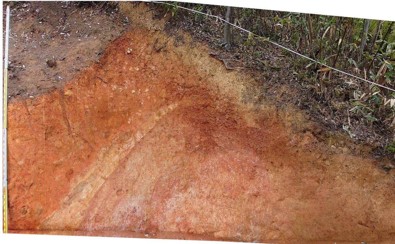
大坪川左岸 表土はぎ写真
