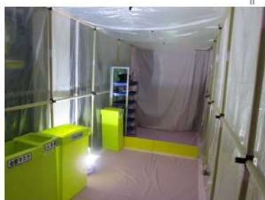
可搬型照明①
