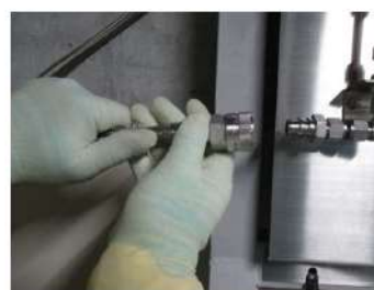
アニュラス全量排気弁操作用可搬型 窒素ガスボンベのカップラ接続 (原子炉補助建屋 T.P. 40.3m)
