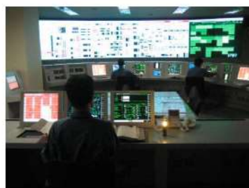
全交流動力電源喪失を想定した訓練
