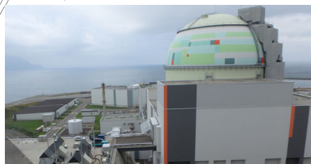
構内監視カメラ①
