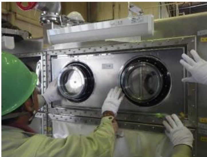
図8. 難燃性パネル取付の様子
