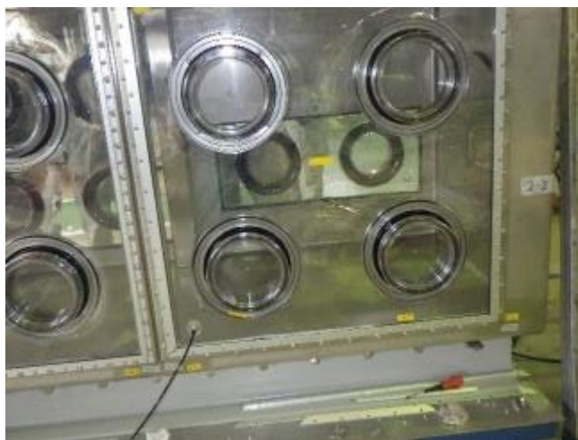
図10. 難燃性パネル施工後の状態
