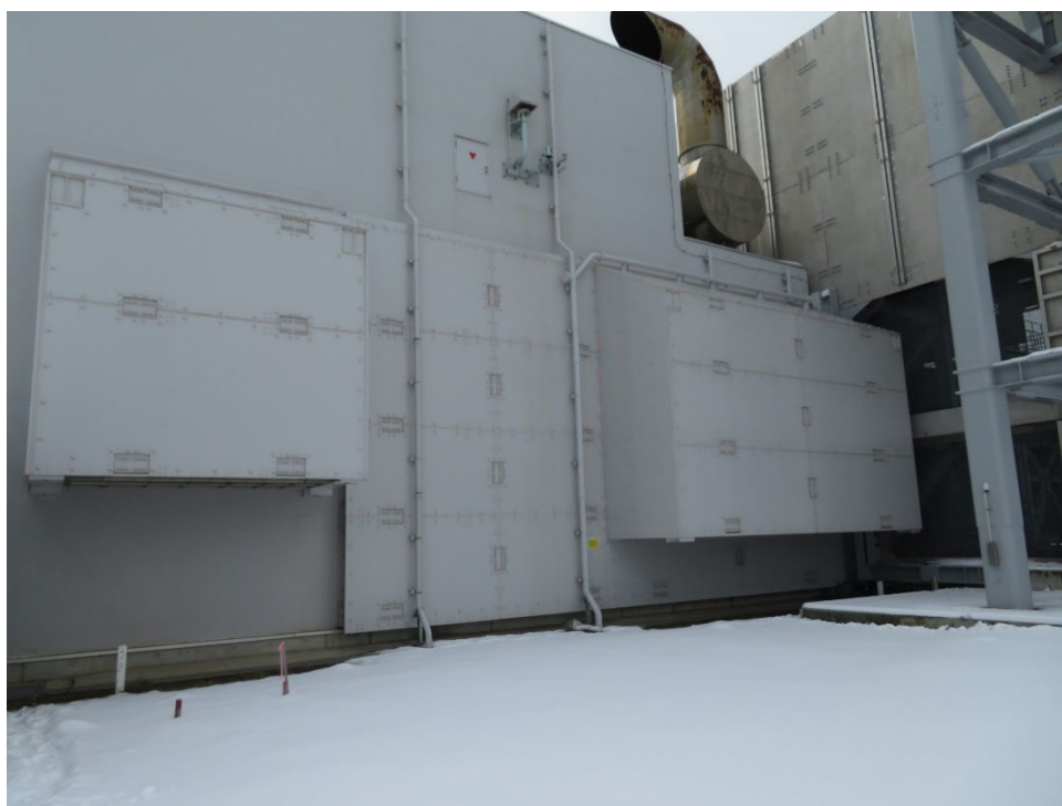
飛来物防護板 写真②(A系統 北面)
