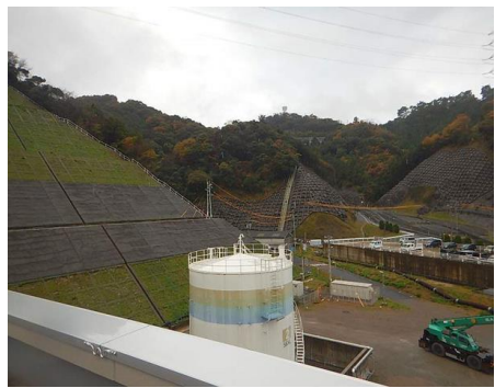
(輪谷貯水槽（西1）および（西2）の南側方向)
