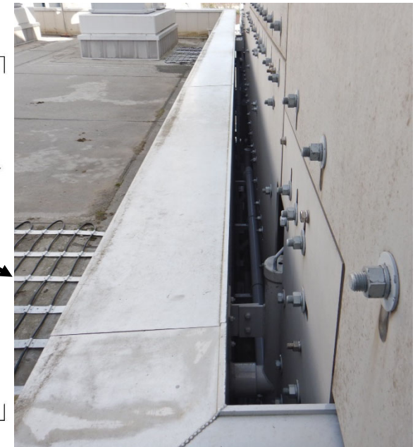
建屋近傍の隙間状況
