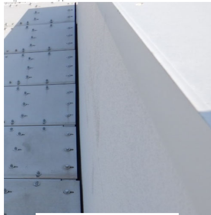
建屋近傍の隙間状況
