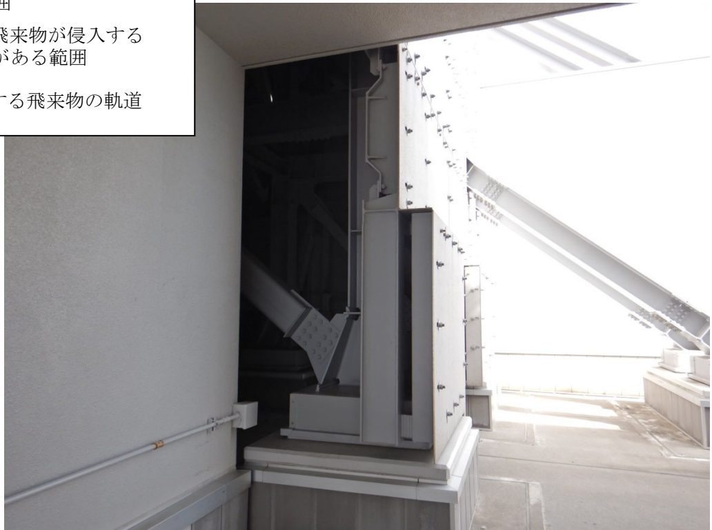
設計飛来物が侵入するおそれがある範囲の隙間状況
