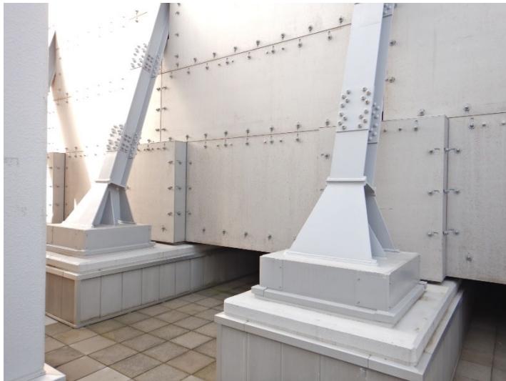
建屋 屋上面との隙間状況
