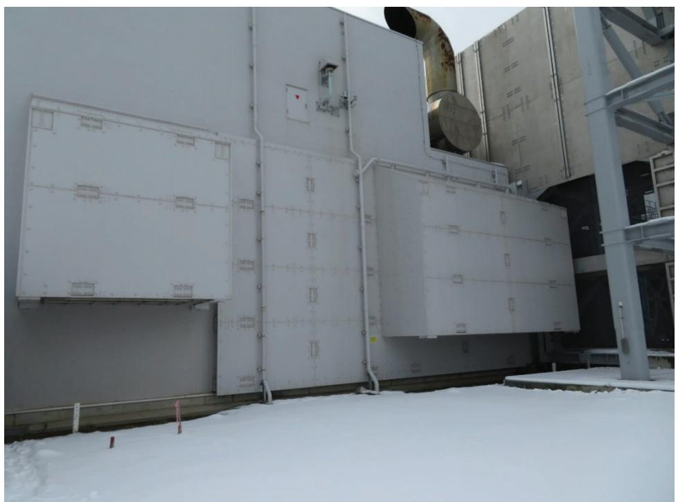
第 1. 2. 1-23 図 飛来物防護板の外観
