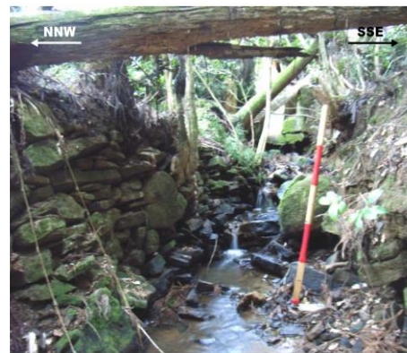
調査箇所① 写真 安山岩が確認される
