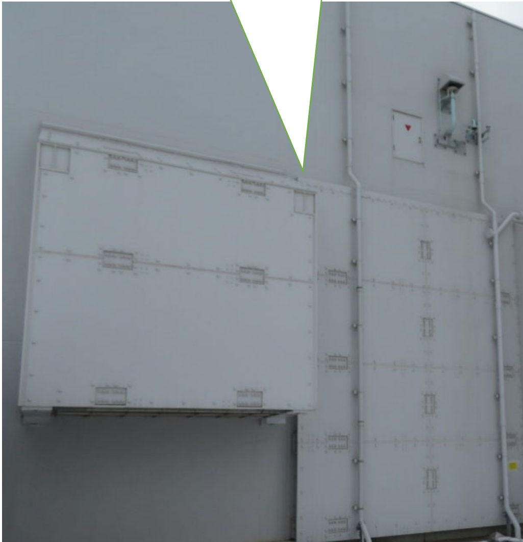
第 1.2.1-16 図 飛来物防護板(GA 建屋) 構造概要図
