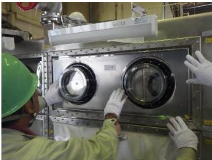
図8. 難燃性パネル取付の様子
