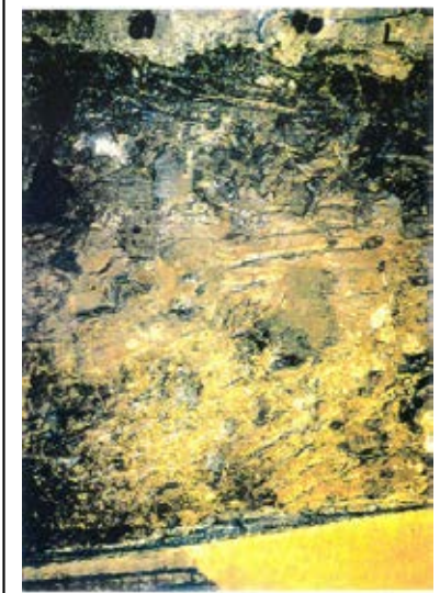
底盤(南側)No.69~70 写真
