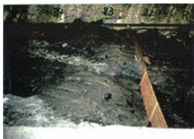
底盤(北側)No.82~84 写真
