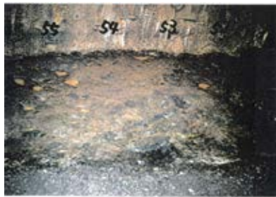
底盤(北側)No.52~55 写真
