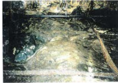
底盤(北側)No.110~112 写真
