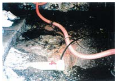
底盤(北側)No.242~244 写真
