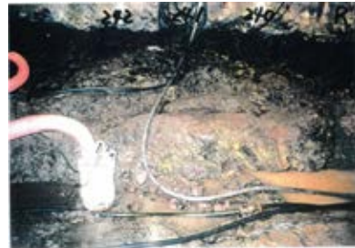
底盤(北側)No.240~242 写真
