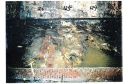
底盤(北側)No.124~126 写真
