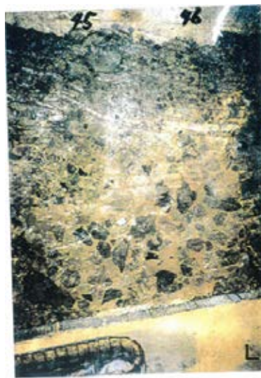
底盤(南側)No.45~46 写真
