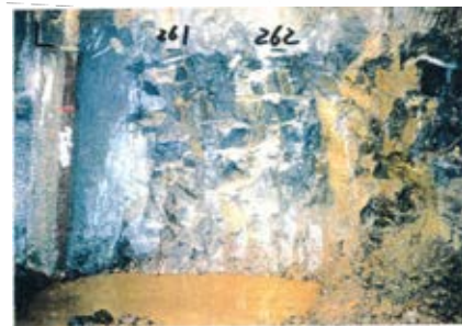
側壁(下半南側)No.261~262 写真
