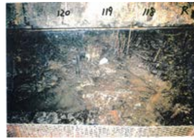
底盤(北側)No.118~120 写真
