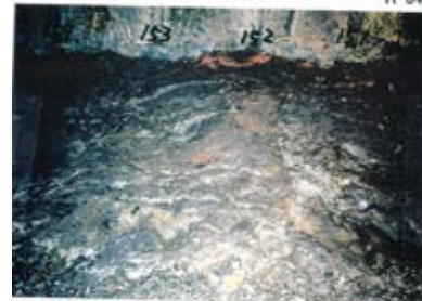
底盤(北側)No.151~154 写真
