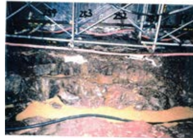
底盤(北側)No.251~254 写真
