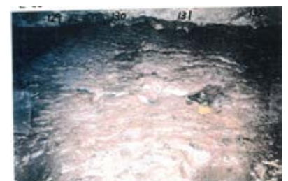
底盤(南側)No.129~132 写真
