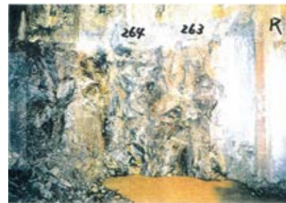
側壁(下半北側)No.263~264 写真
