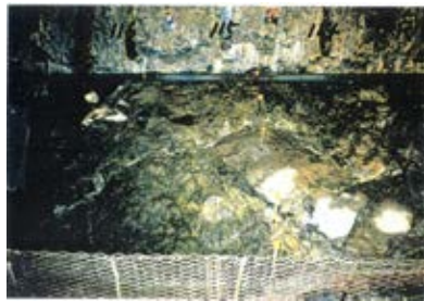
底盤(北側)No.114~116 写真
