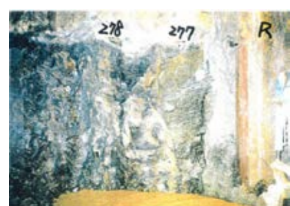
側壁(下半北側)No.277~278 写真
