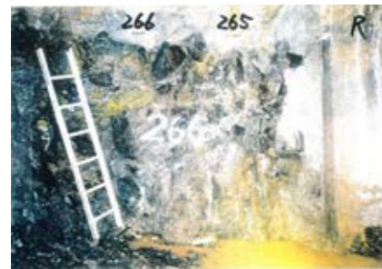
側壁(下半北側)No.265~266 写真
