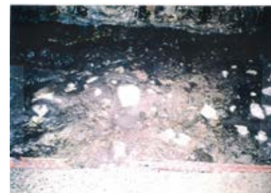
底盤(南側)No.153~155 写真
