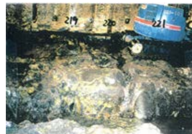
底盤(南側)No.219~221 写真
