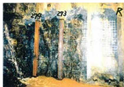
側壁(下半北側)No.273~274 写真
