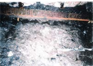
底盤(北側)No.9~10 写真
