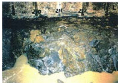
底盤(南側)No.210~212 写真
