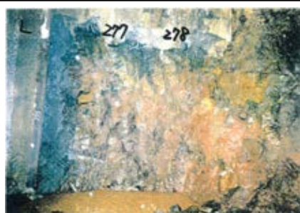
側壁(下半南側)No.277~278 写真
