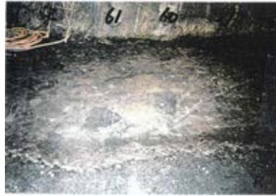
底盤(北側)No.60~61 写真
