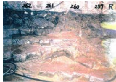
底盤(北側)No.259~262 写真
