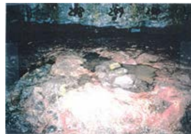
底盤(南側)No.248~249写真
