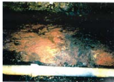
底盤(北側)No.273~275 写真
