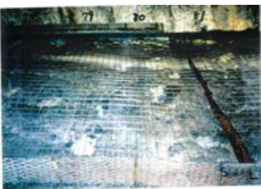
底盤(南側)No.78~81 写真
