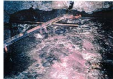
底盤(南側)No.2~3 写真
