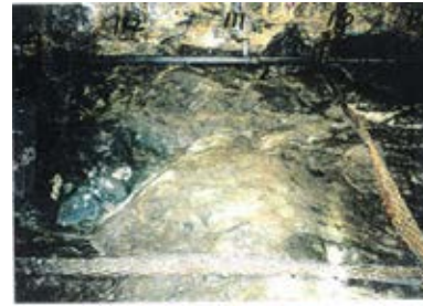
底盤(北側)No.110~112 写真
