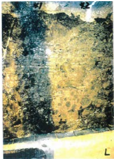
底盤(南側)No.41~42 写真
