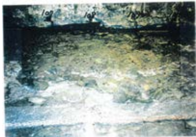
底盤(南側)No.107~109 写真
