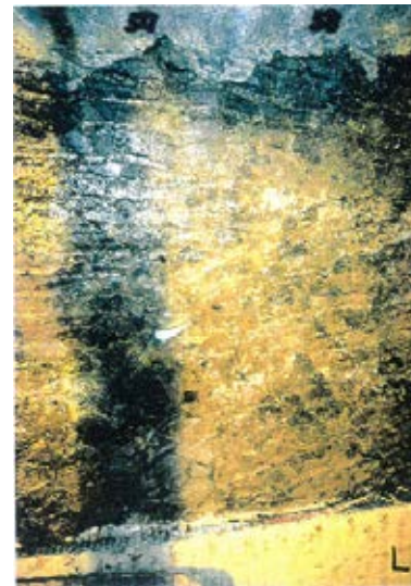
底盤(南側)No.57~58 写真
