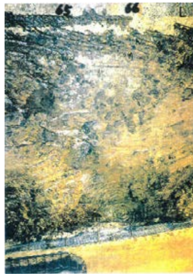
底盤(南側)No.65~66 写真
