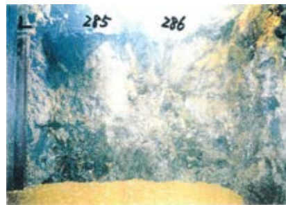
側壁(下半北側)No.285~286 写真
