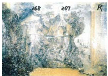
側壁(下半北側)No.267~268 写真
