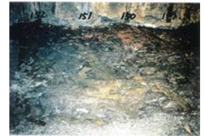
底盤(北側)No.149~152 写真
