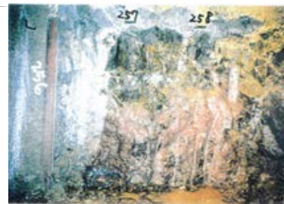
側壁(下半南側)No.257~258 写真
