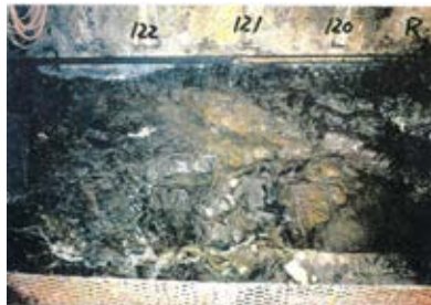
底盤(北側)No.120~122 写真
