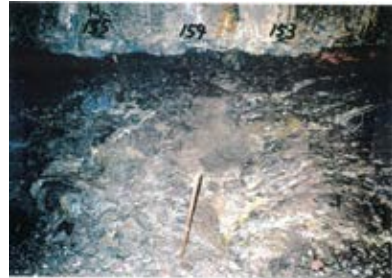
底盤(北側)No.153~155 写真
