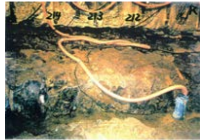
底盤(北側)No.212~214 写真
