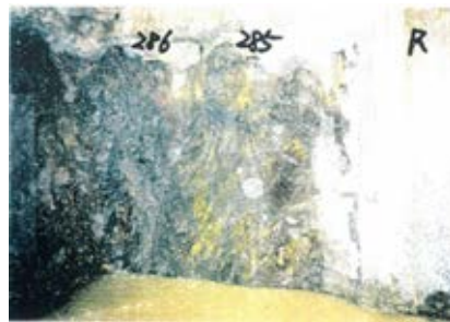
側壁(下半南側)No.285~286 写真
