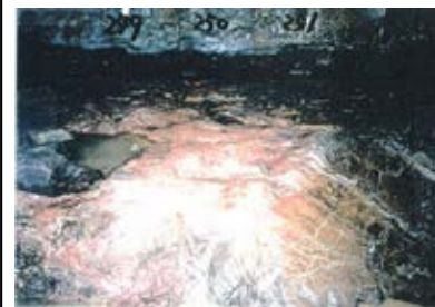
底盤(南側)No.249~251写真
