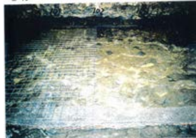
底盤(南側)No.101~103 写真
