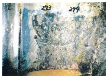
側壁(下半南側)No.273~274 写真
