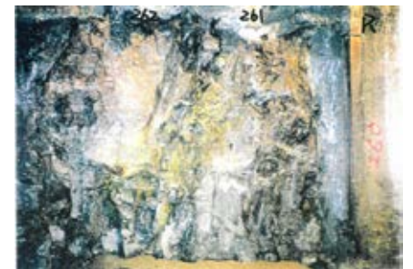
側壁(下半北側)No.261~262 写真
