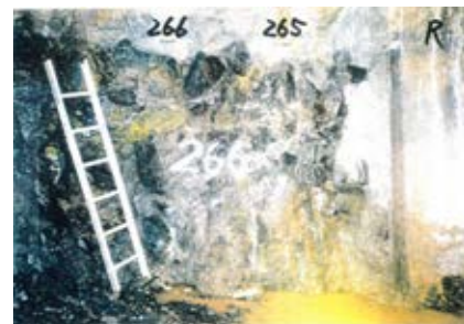
側壁(下半北側)No.265~266 写真
