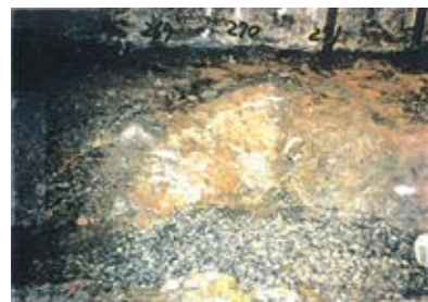
底盤(南側)No.269~271 写真
