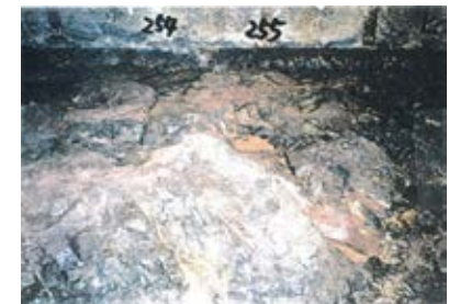
底盤(南側)No.254~255 写真
