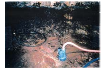
底盤(北側)No.256~258 写真
