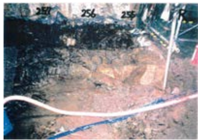
底盤(北側)No.255~257 写真
