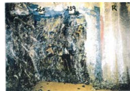
側壁(下半北側)No.259~260 写真
