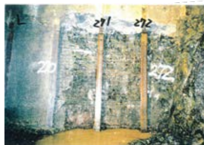
側壁(下半南側)No.271~272 写真
