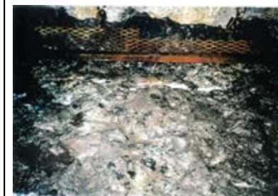
底盤(南側)No.9~10 写真
