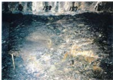
底盤(北側)No.156~159 写真
