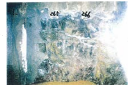
側壁(下半南側)No.265~266 写真
