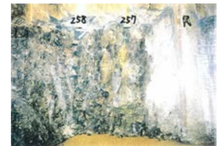
側壁(下半北側)No.257~258 写真
