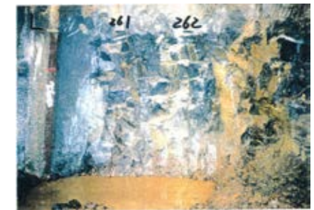
側壁(下半南側)No.261~262 写真
