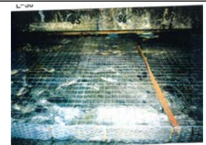
底盤(南側)No.85~87 写真
