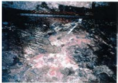
底盤(南側)No.5~6 写真
