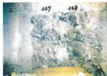
側壁(下半南側)No.267~268 写真
