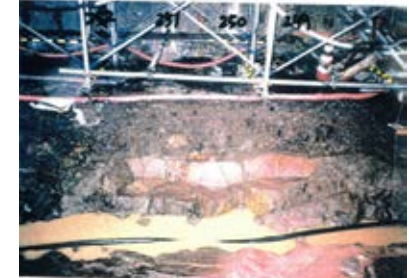
底盤(北側)No.249~252 写真
