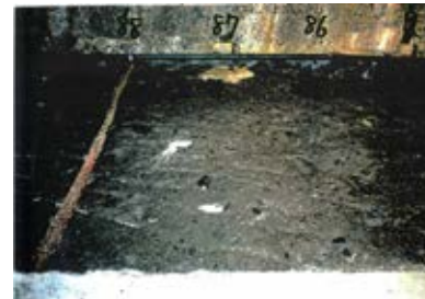
底盤(北側)No.86~88 写真
