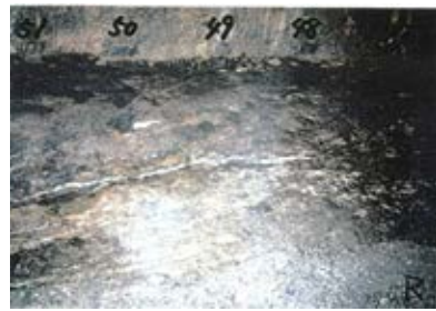
底盤(北側)No.48~51 写真
