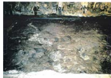
底盤(北側)No.100~102 写真
