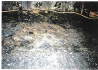
底盤(北側)No.62~65 写真
