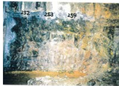
側壁(下半南側)No.252~254 写真
