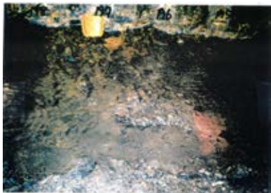
底盤(北側)No.195~198 写真
