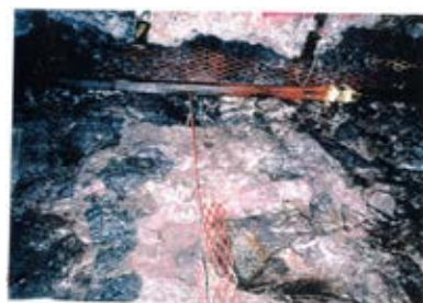
底盤(南側)No.7~8 写真
