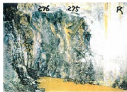
側壁(下半北側)No.275~276 写真
