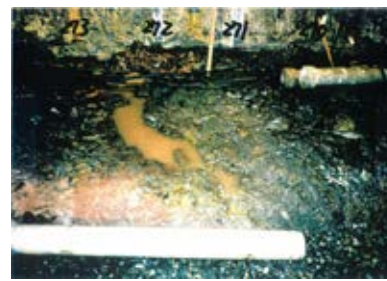
底盤(北側)No.270~273 写真
