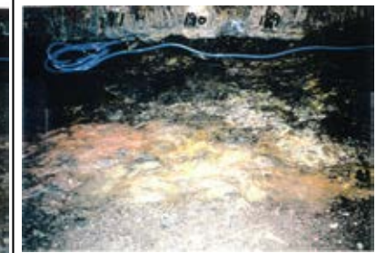
底盤(北側)No.189~191 写真
