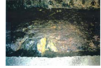
底盤(南側)No.194~197 写真
