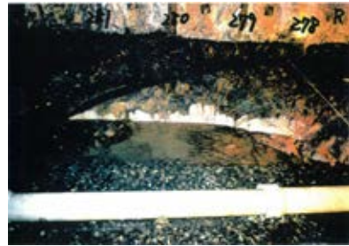
底盤(北側)No.279~281 写真
