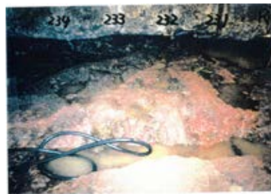
底盤(北側)No.231~234 写真
