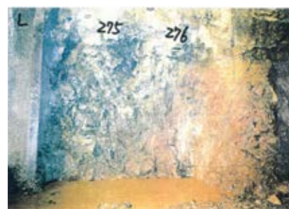
側壁(下半南側)No.275~276 写真
