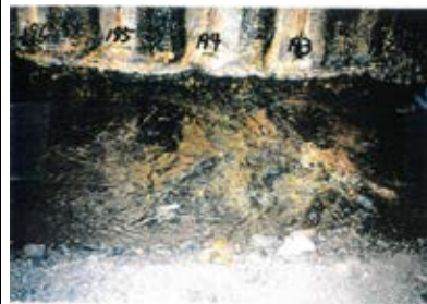
底盤(北側)No.192~196 写真
