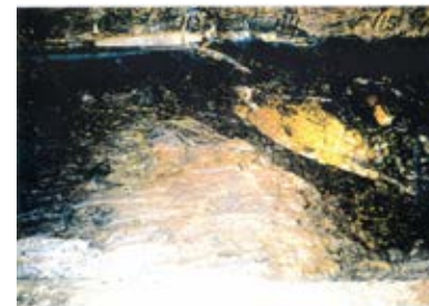
底盤(南側)No.113~115 写真
