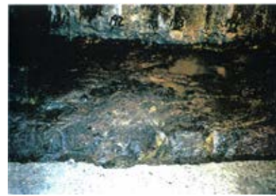
底盤(南側)No.191~194 写真
