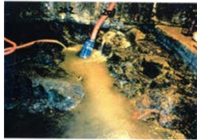
底盤(北側)No.200~202 写真
