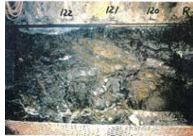
底盤(北側)No.120~122 写真
