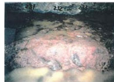
底盤(南側)No.231~233 写真
