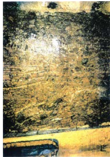
底盤(南側)No.54~56 写真
