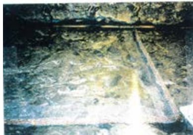
底盤(南側)No.109~111 写真
