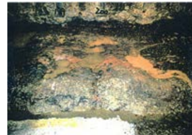
底盤(南側)No.199~200 写真
