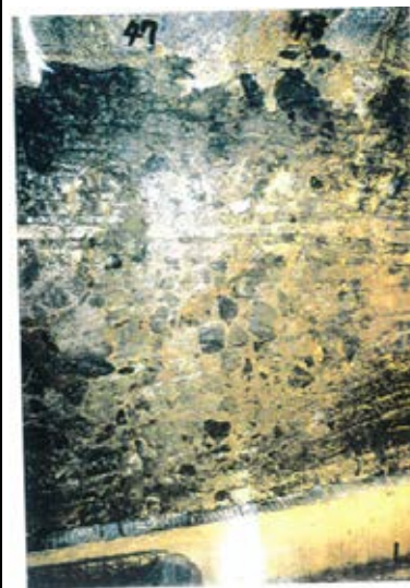
底盤(南側)No.47~48 写真
