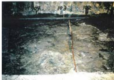
底盤(北側)No.102~104 写真
