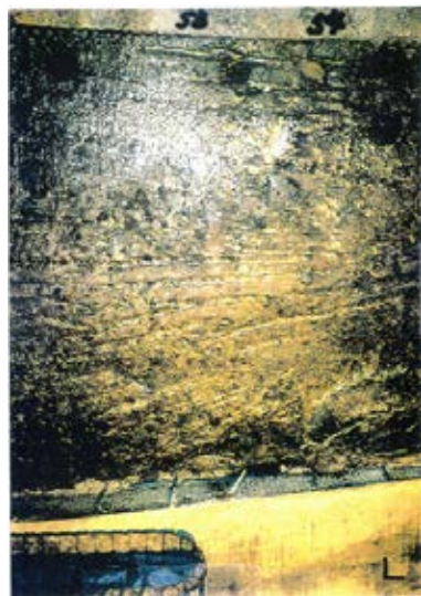
底盤(南側)No.53~54 写真
