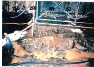
底盤(北側)No.252~256 写真
