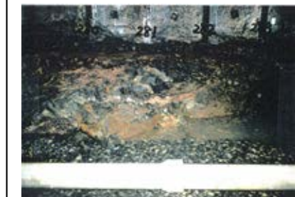
底盤(南側)No.280~283 写真
