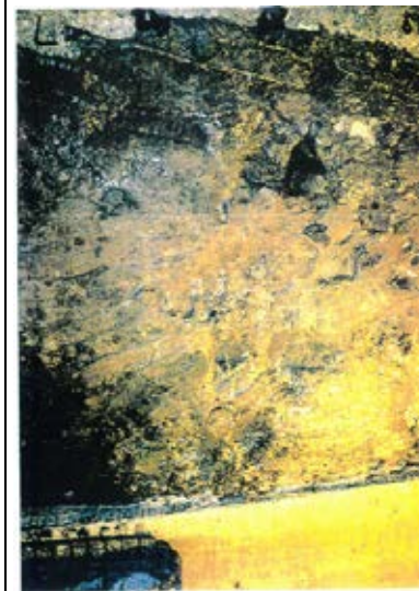
底盤(南側)No.67~69 写真
