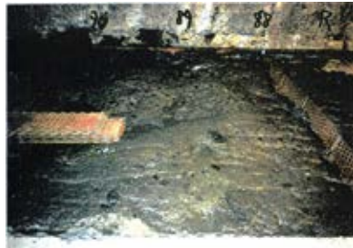
底盤(北側)No.88~90 写真
