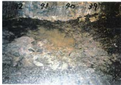
底盤(北側)No.39~42 写真
