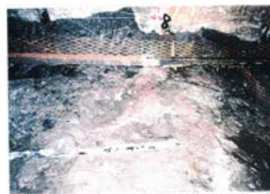
底盤(北側)No.7~9 写真
