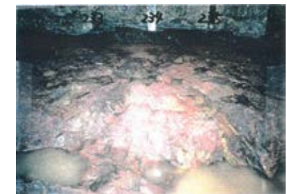
底盤(南側)No.233~235 写真
