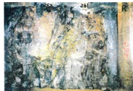
側壁(下半北側)No.261~262 写真
