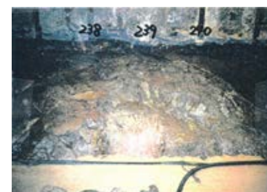
底盤(南側)No.238~240 写真
