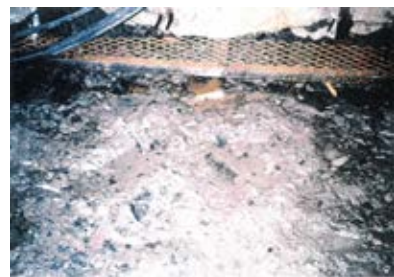
底盤(北側)No.10~11 写真
