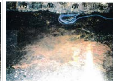
底盤(北側)No.190~193 写真
