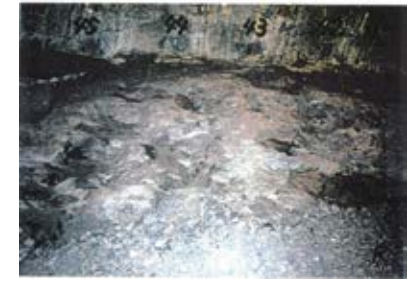
底盤(北側)No.42~45 写真
