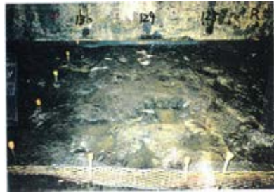
底盤(北側)No.128~130 写真
