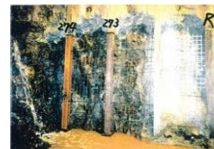
側壁(下半北側)No.273~274 写真
