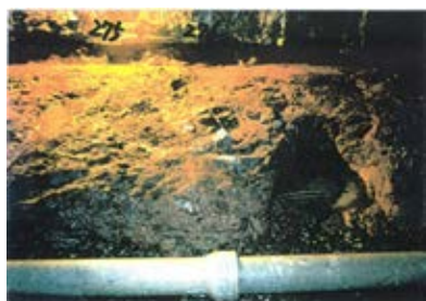
底盤(南側)No.275~277 写真
