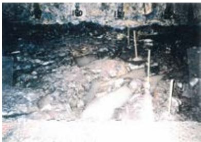
底盤(南側)No.149~152 写真
