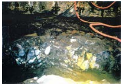
底盤(北側)No.214~216 写真
