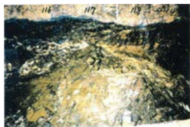
底盤(南側)No.116~119 写真
