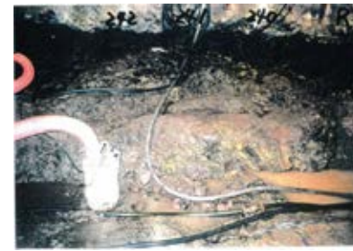
底盤(北側)No.240~242 写真
