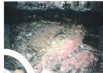
底盤(南側)No.243~245 写真
