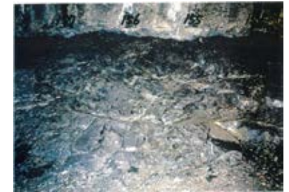
底盤(北側)No.154~157 写真
