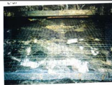
底盤(南側)No.83~85 写真
