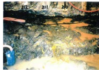
底盤(北側)No.210~212 写真
