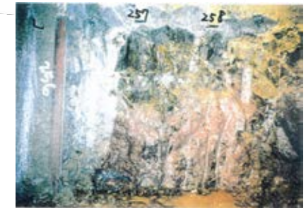
側壁(下半南側)No.257~258 写真
