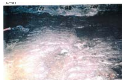
底盤(南側)No.127~129 写真
