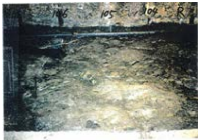
底盤(北側)No.104~106 写真
