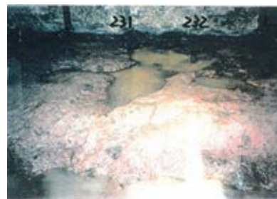
底盤(南側)No.231~232 写真
