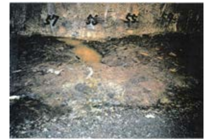
底盤(北側)No.54~57 写真
