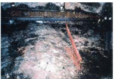
底盤(北側)No.3~5 写真
