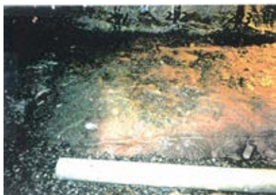
底盤(南側)No.271~273 写真
