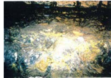
底盤(北側)No.218~219 写真
