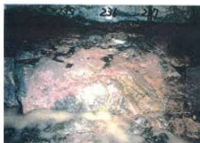
底盤(南側)No.235~237 写真
