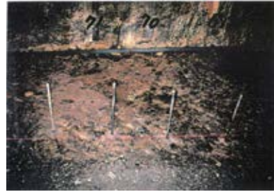
底盤(北側)No.69~71 写真
