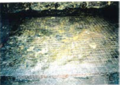
底盤(南側)No.99~101 写真
