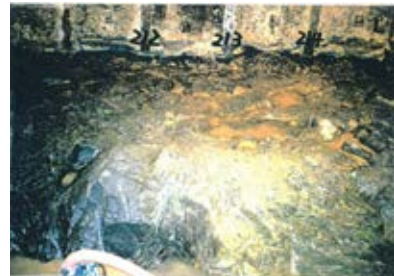
底盤(南側)No.212~214 写真
