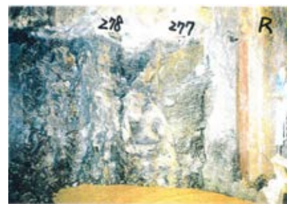
側壁(下半北側)No.277~278 写真
