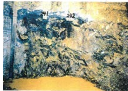
側壁(下半南側)No.241~242 写真
