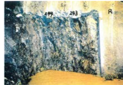
側壁(下半北側)No.243~244 写真
