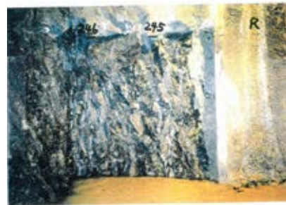
側壁(下半北側)No.245~246 写真
