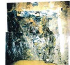
側壁(下半北側)No.241~242 写真
