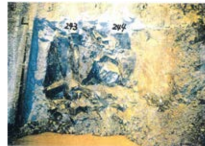
側壁(下半南側)No.243~244 写真
