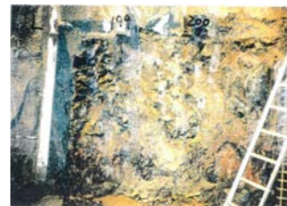
側壁(下半南側)No.199~200 写真
