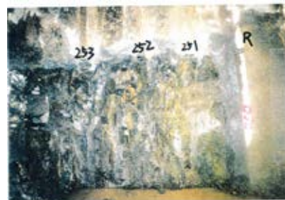
側壁(下半北側)No.251~253 写真
