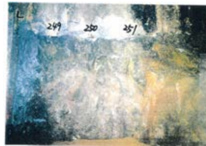
側壁(下半南側)No.249~251 写真
