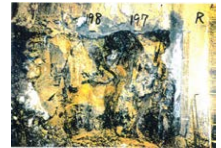
側壁(下半北側)No.197~198 写真
