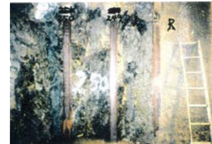
側壁(下半北側)No.249~250 写真
