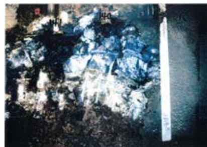
側壁(下半北側)No.140~141 写真
