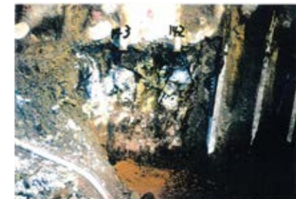
側壁(下半北側)No.142~143 写真
