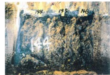
側壁(下半南側)No.144~146 写真
