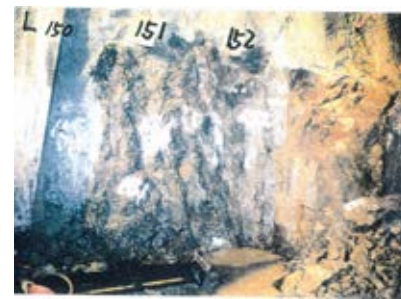
側壁(下半南側)No.150~152 写真
