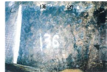
側壁(下半南側)No.136~137 写真
