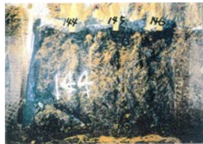
側壁(下半南側)No.144~146 写真
