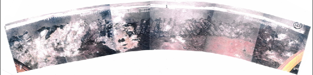
側壁(上半)No.121 写真
