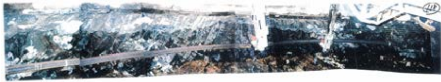
側壁(上半)No.118 写真
