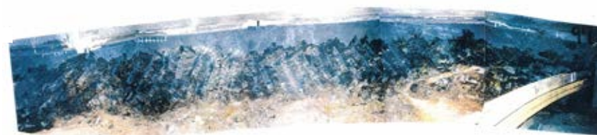
側壁(上半)No.97 写真
