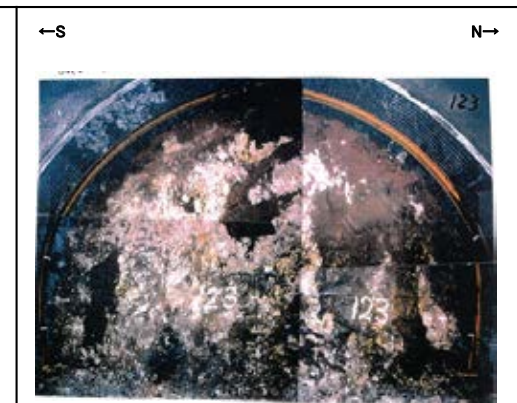
切羽No.123 写真
