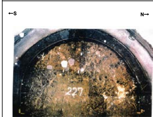
切羽No.227 写真
