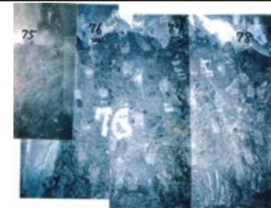
側壁(下半南側)No.75~78 写真
