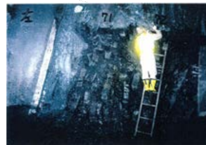
側壁(下半南側)No.71~72 写真
