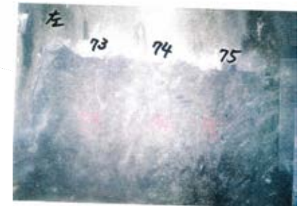
側壁(下半南側)No.73~75 写真
