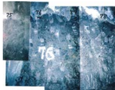
側壁(下半南側)No.75~78 写真
