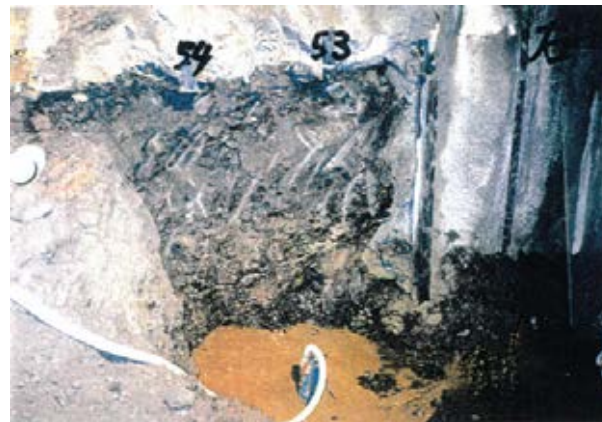
側壁(下半北側)No.53~54 写真
