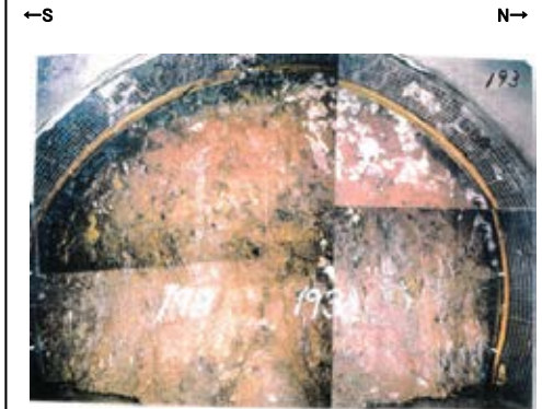
切羽No.193 写真
