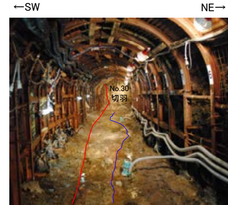
横坑の状況写真 (立坑側より, 2013年撮影)
