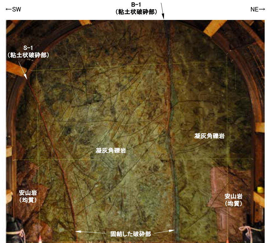
No.11切羽写真(割れ目等を加筆)
