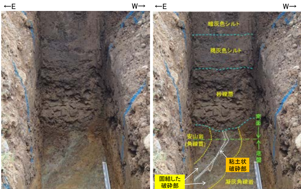
南面 拡大写真
