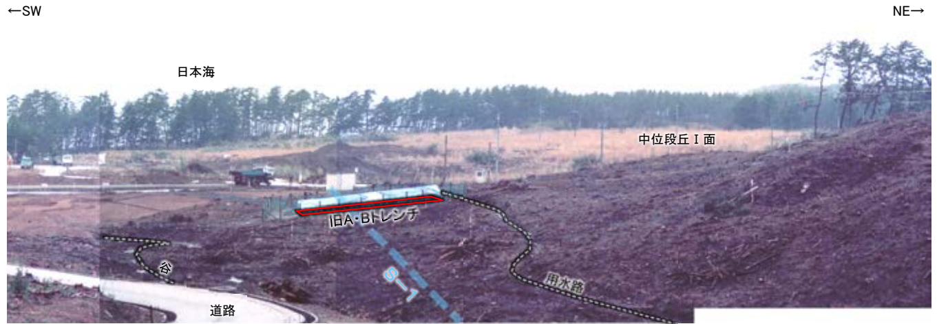
建設時写真(樹木伐採後)(トレンチ位置等を加筆)
