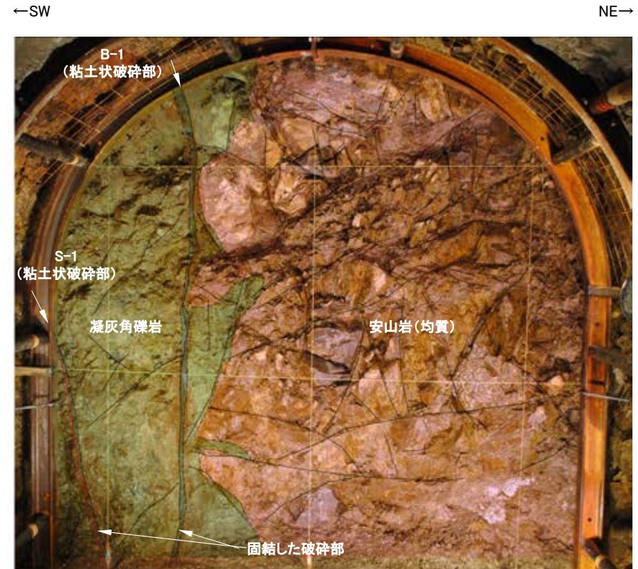
No.4切羽写真(割れ目等を加筆)
