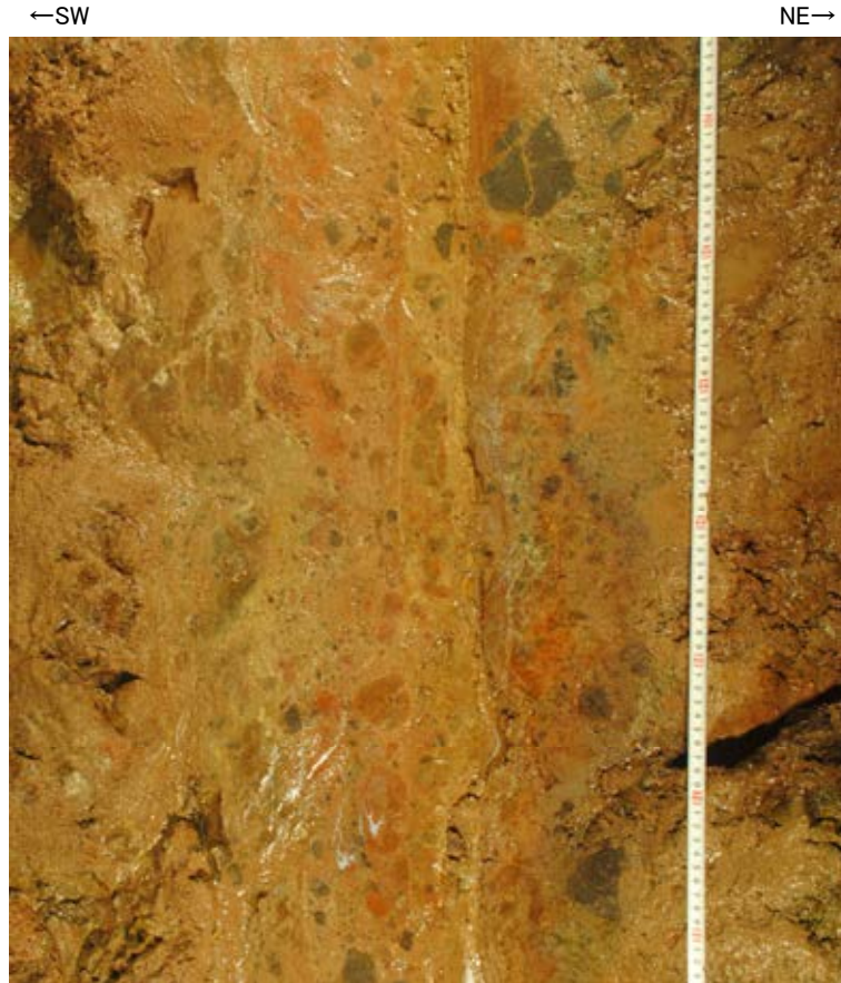
No.21付近底盤写真
