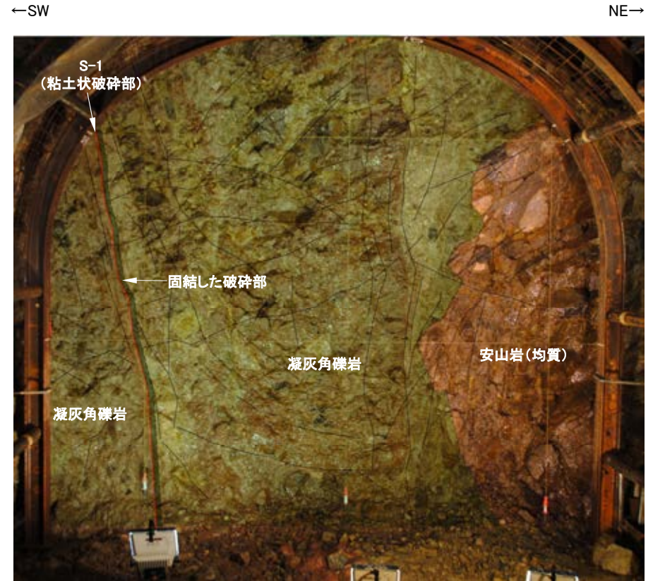
No.28切羽写真(割れ目等を加筆)
