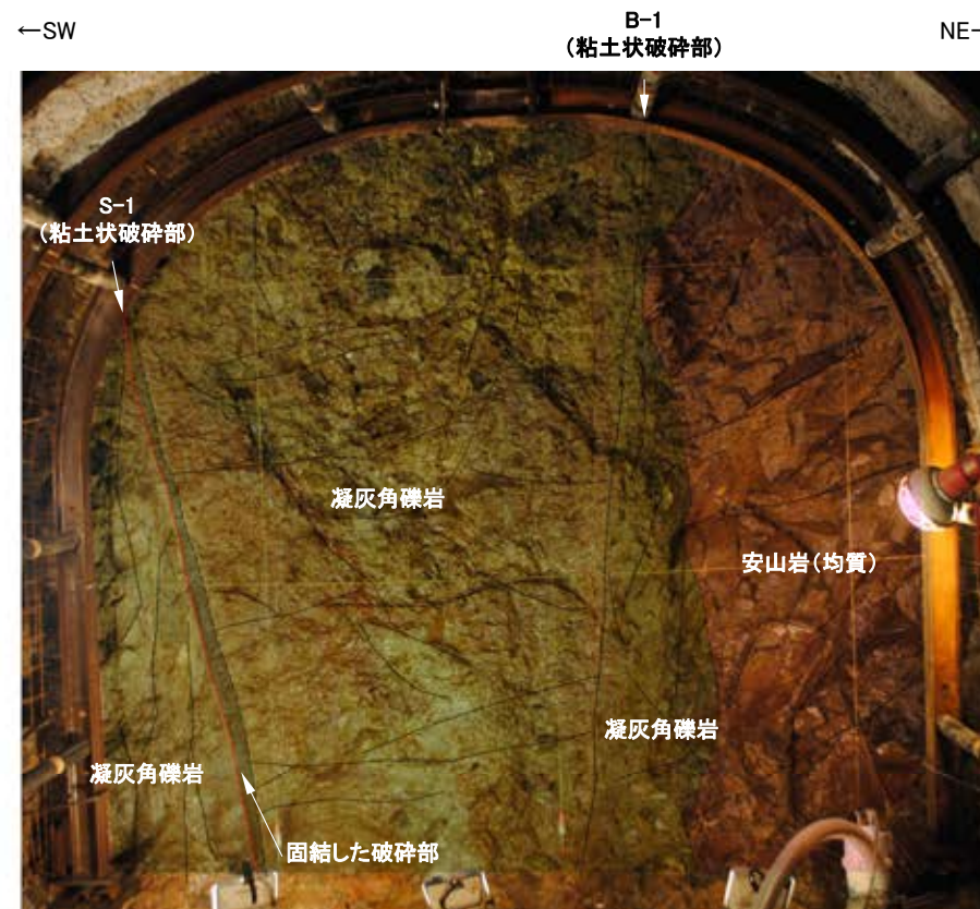
No.26切羽写真(割れ目等を加筆)
