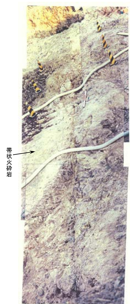
原子炉建屋底盤(EL-7.1m) S-1付近 写真
