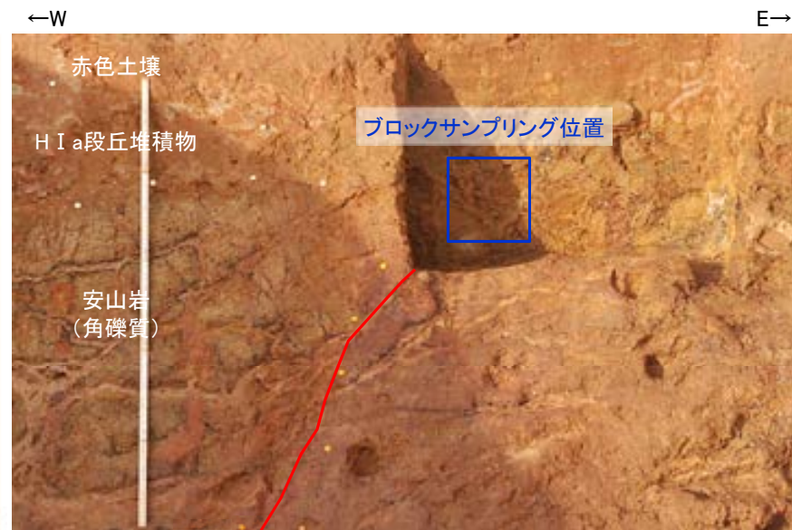
写真② 新北面:掘り込み後写真(2022年11月撮影)
