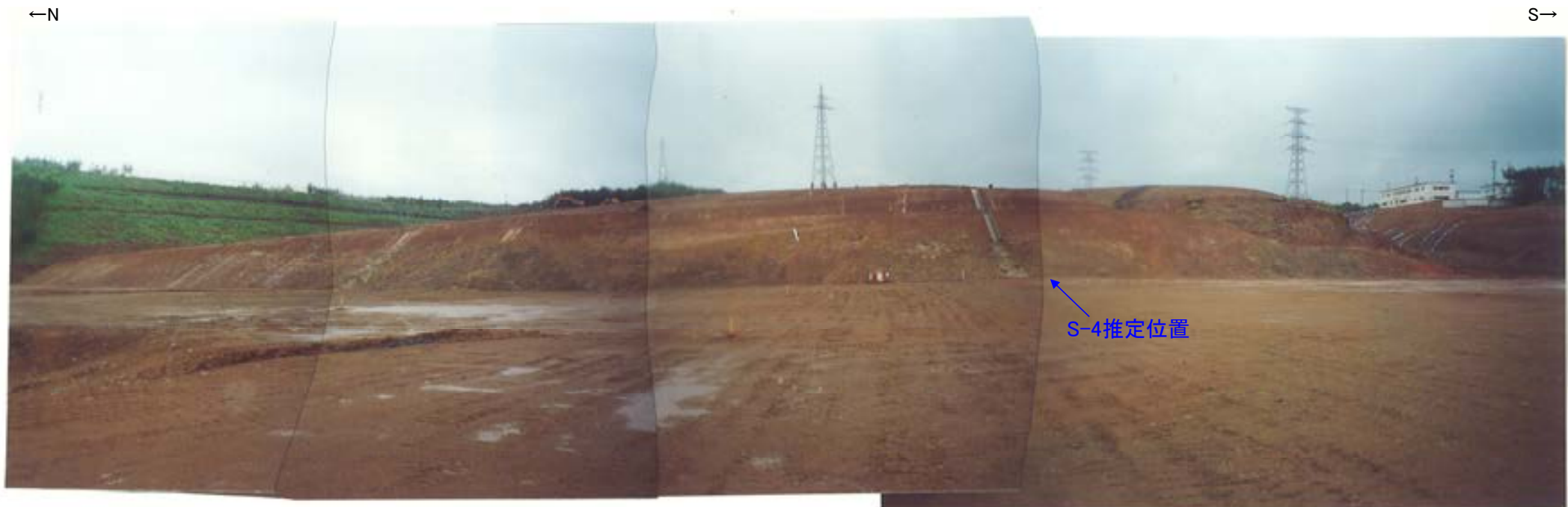
写真(2号機建設時)
