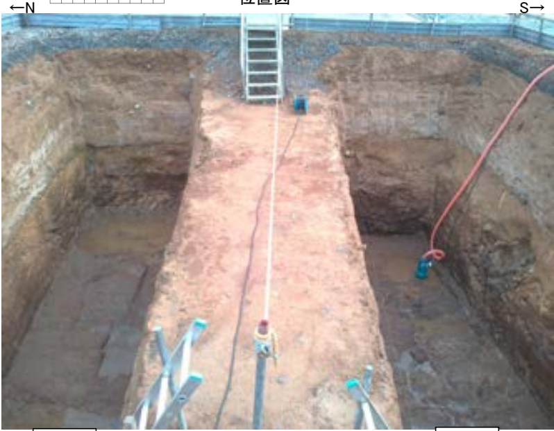
北側 トレンチ状況写真(西側から撮影) 南側
