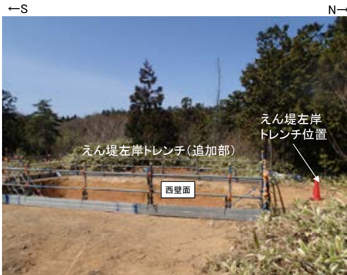
トレンチ状況写真(東側から撮影)
