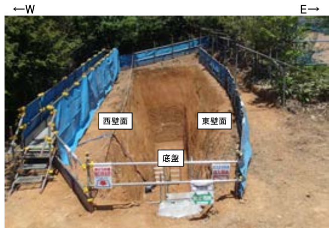
トレンチ状況写真(南側から撮影)
