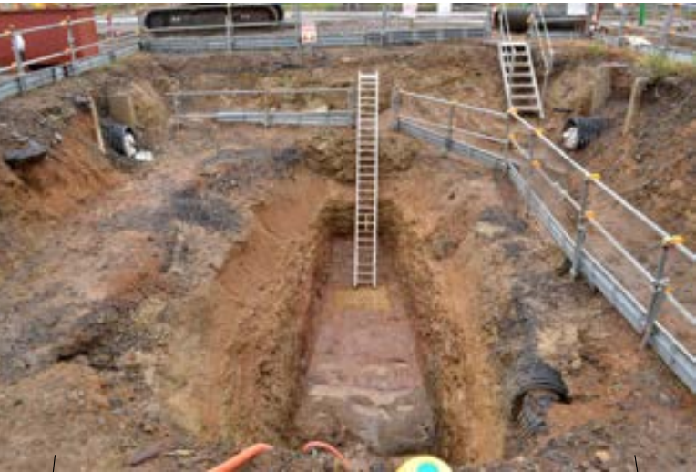
トレンチ全景写真(西側から撮影)
