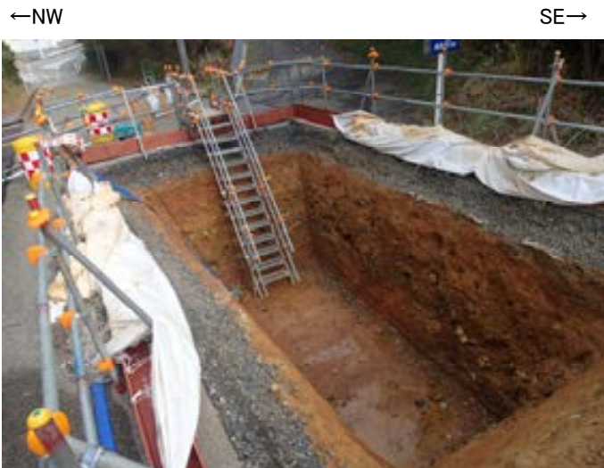
トレンチ状況写真(南西側から撮影)
