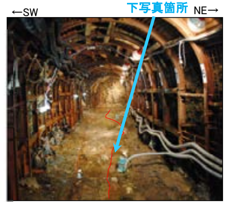
岩盤調査坑写真(全景写真)
