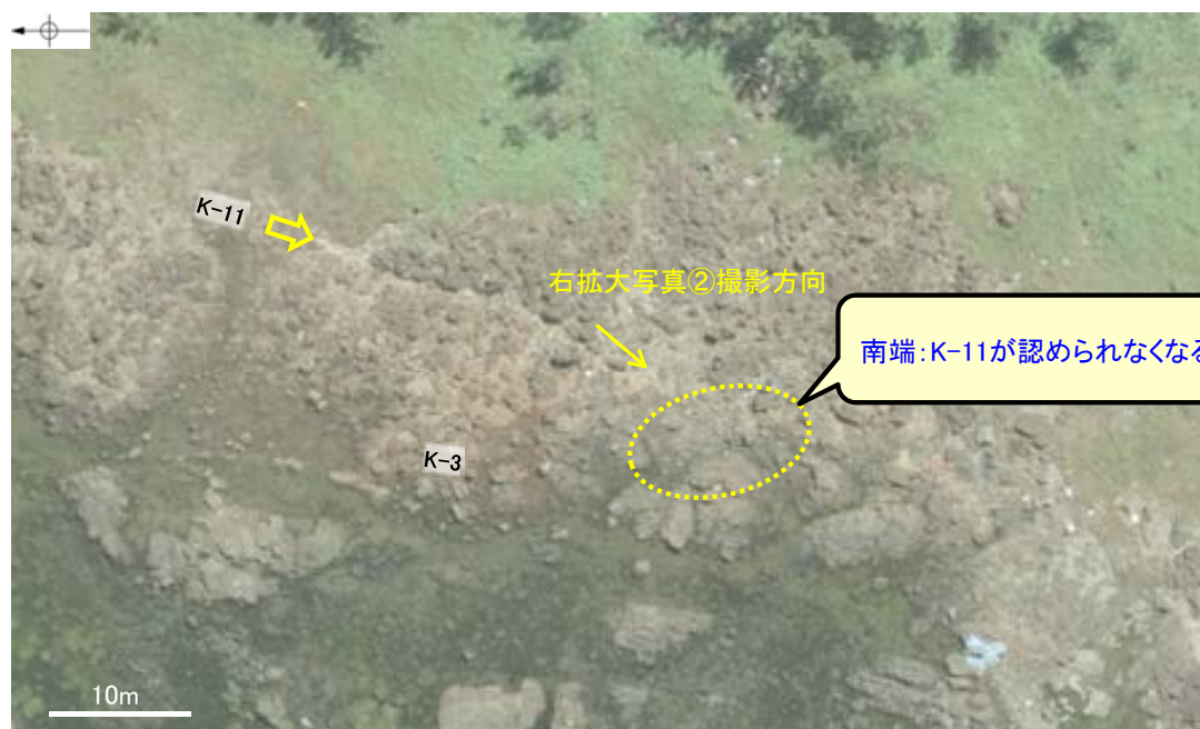
拡大写真① K-11の南方付近
