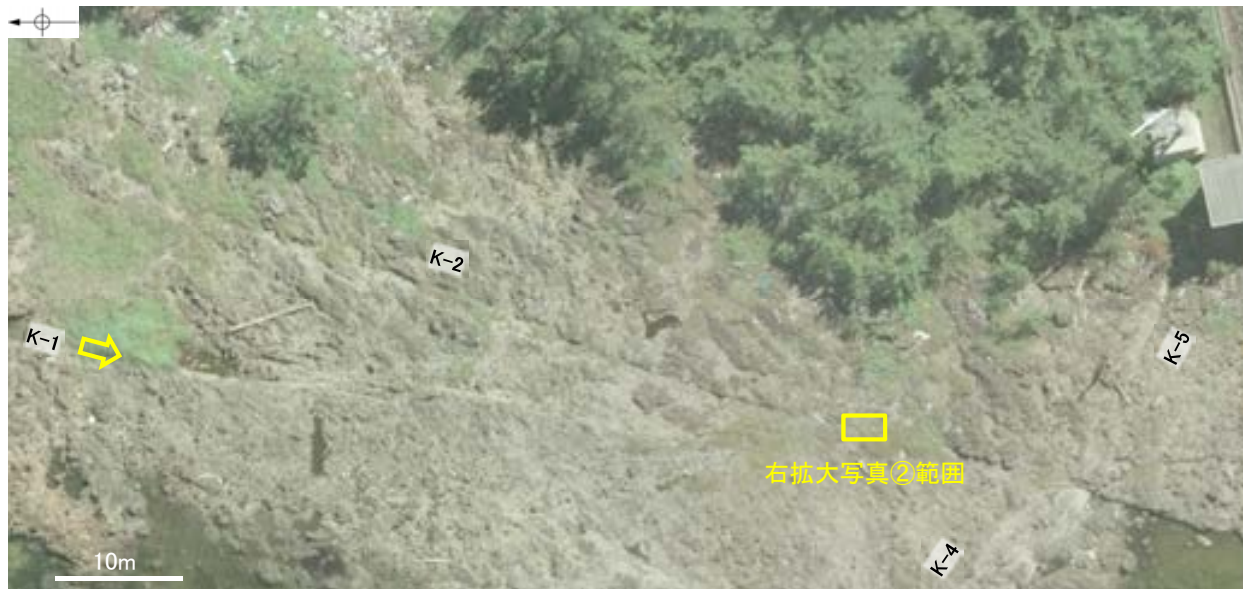
拡大写真① K-1の南方付近
