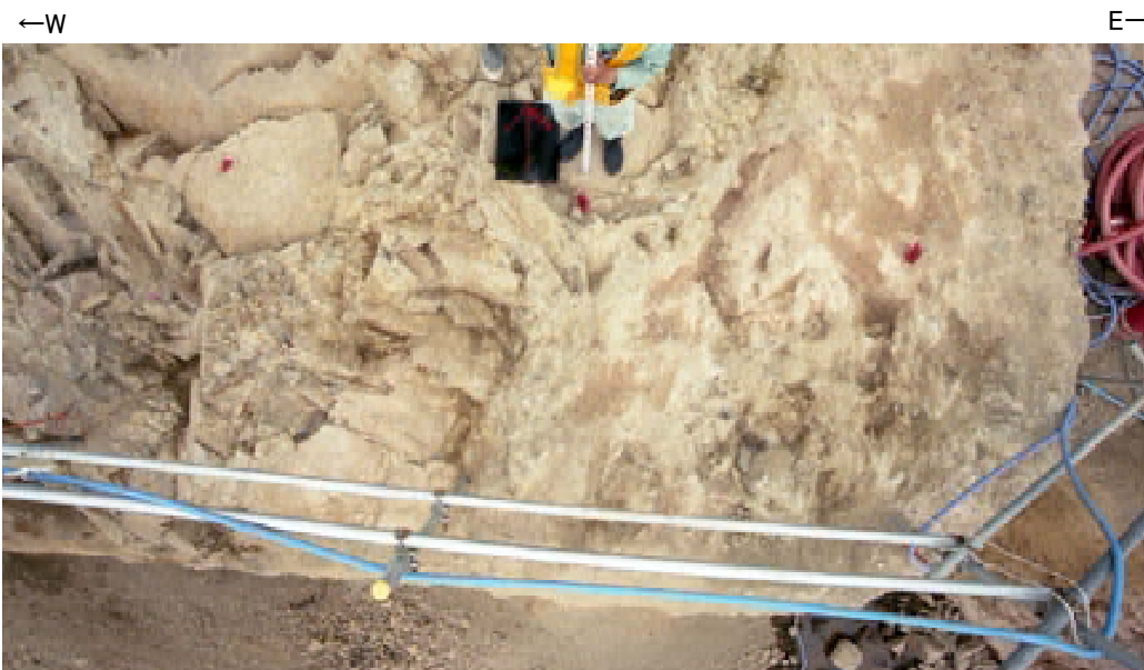
写真② 2号機地下式軽油タンク(DBA)連絡ダクト底盤 S-4端部
