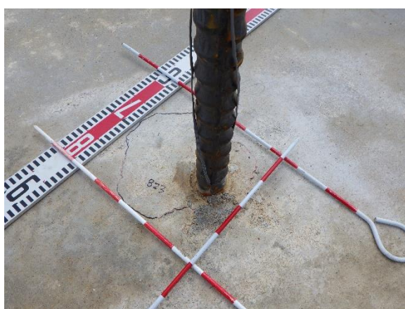
(a) 「浮き」除去前
