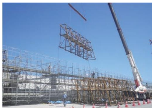
2. 鉄筋架台の設置
