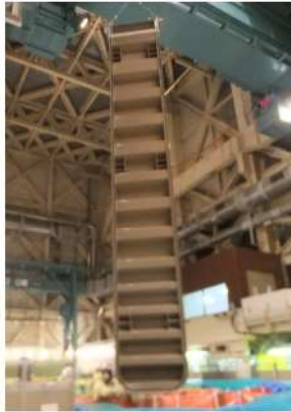
ゲート吊上げ作業 (写真は2号機)
