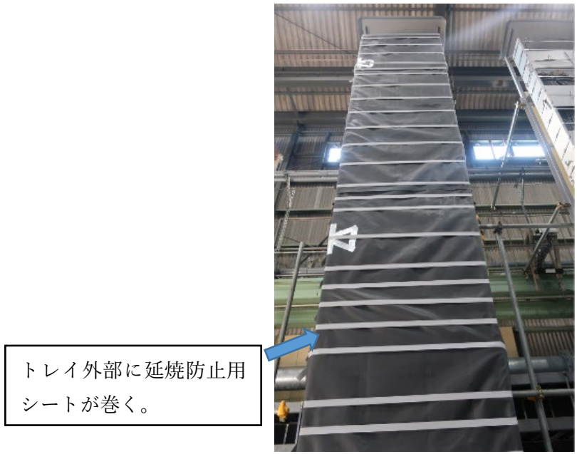
第19図 ラダートレイの消火実証試験装置の外観(垂直)
