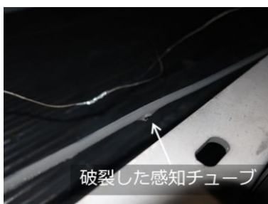
第34図 試験⑤における発火・消火時の状態
