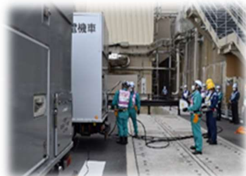
＜中国電力殿電源車接続訓練＞
