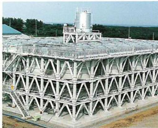
第 4-1 図 安全冷却水冷却塔のイメージ
