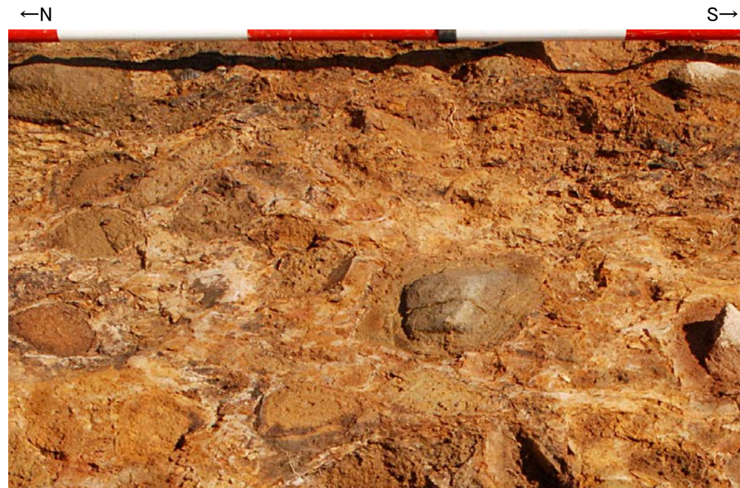
35m盤法面 堆積物の拡大写真
