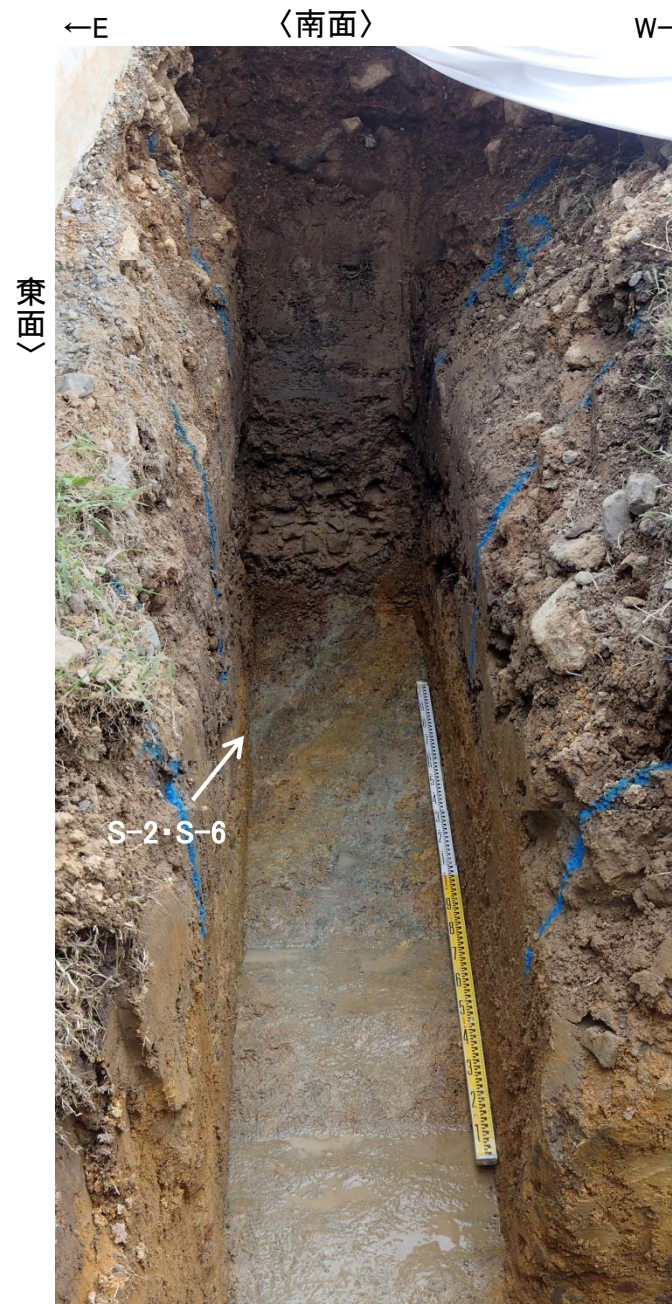
写真(事務本館前トレンチ)
