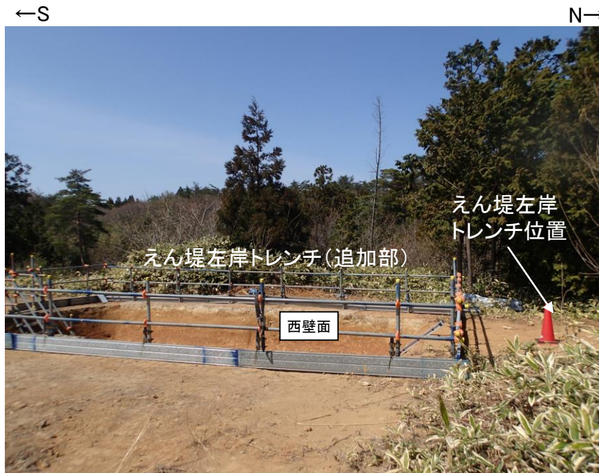
トレンチ状況写真(東側から撮影)
